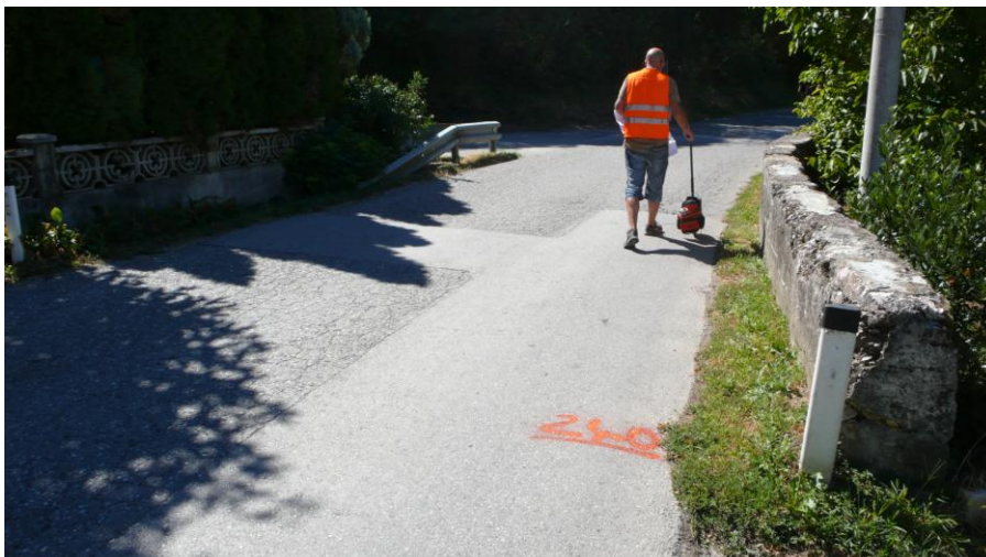
Slika 2: km 0,240 – prepust čez potok
