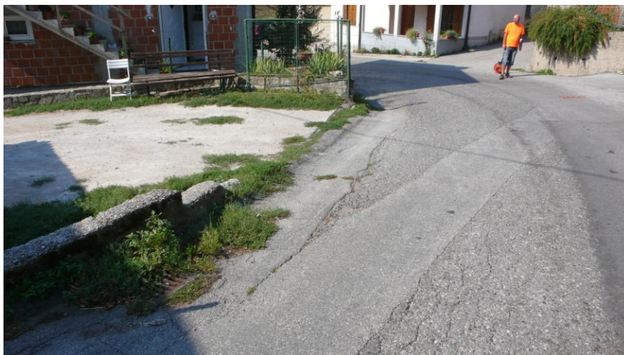
Slika 15: km 2,660 – obstoječe stanje
