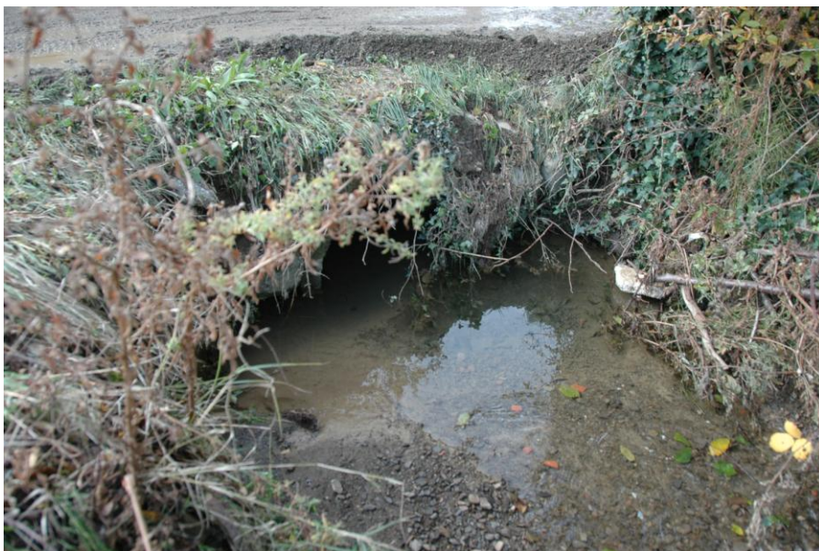
Slika 9: km 0,752 – cevni prepust (datum 30.10.2012)
