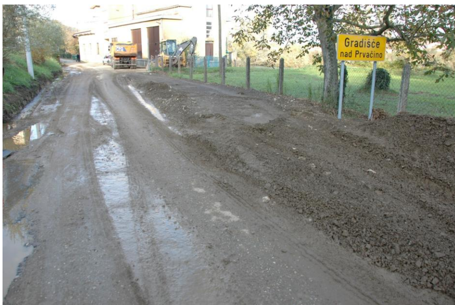
Slika 8: km 0,752 – cevni prepust (datum 30.10.2012)
