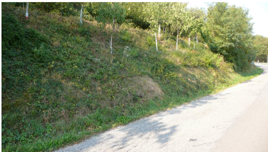
Slika 12: km 1,960 – območje ureditve oporne konstrukcije
