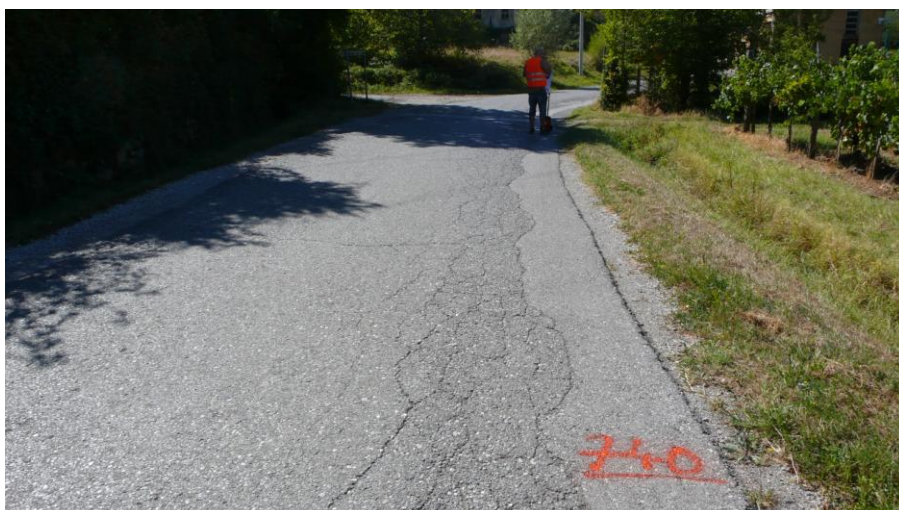
Slika 7: km 0,752 – cevni prepust
