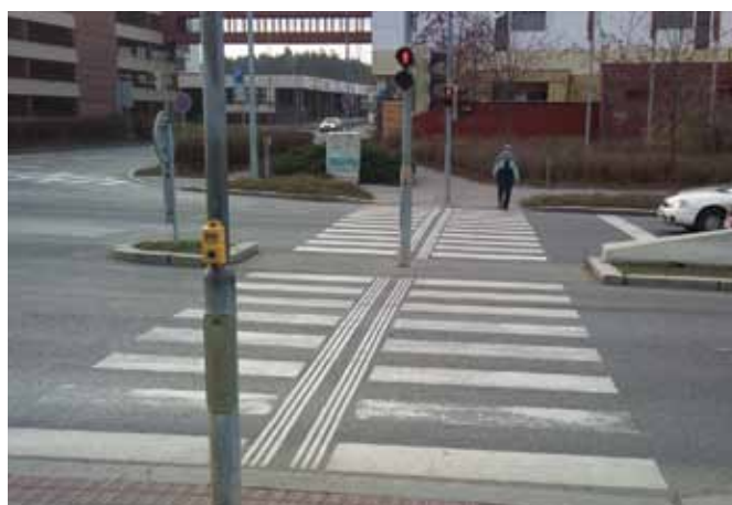
SLIKA 64 Primer vodilne linije čez vozišče
