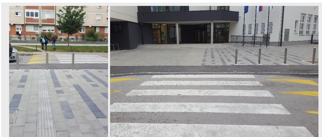
Sliki 27 (neustrezno): Primer neusklajenega načrtovanja ceste in zunanje ureditve pri šoli. 1 Taktilna vodilna linija, ki vodi do vhoda v šolo, se na drugem koncu zaključi na robu pločnika brez čepaste oznake, ki bi označevala zaključek taktilnega vodenja. Če pešec nadaljuje naprej v isti smeri, pride do prehoda za pešce (ki ni taktilno označen) in sicer izven območja zebre. Neposredno ob taktilni liniji stoji količek, v katerega se uporabnik bele palice zaleti, če hodi ob taktilni oznaki po desni strani. 2 Kontrastni vzorci v tlaku poudarjajo vhod v šolo, ki je na desni strani, vendar je takšen poudarek zavajajoč, saj ni ustrezno povezan s prehodom za pešce. Vzorci v tlaku bi v tem primeru morali usmerjati od prehoda za pešce proti vhodu, saj je ključno poudariti varno pot do šole.
