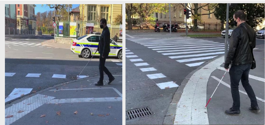
Slika 18: Taktilne oznake v križišču s poglobljenimi robniki v primeru kolesarskega pasu na pločniku. 1 (neustrezno): Na mestu kolesarskega prehoda je taktilna oznaka prekinjena, uporabnik bele palice pa je zaradi nepredvidenega dogodka izgubil orientacijo in v iskanju oprijemljivega roba zašel v križišče. 2 (ustrezno): Taktilne oznake označujejo rob ceste tudi na prehodu kolesarske steze. Uporabnik bele palice, ki je zaradi nepredvidenega dogodka izgubil orientacijo, otipa rob, po kateremu lahko sledi do varne orientacijske točke (npr. semaforja).
