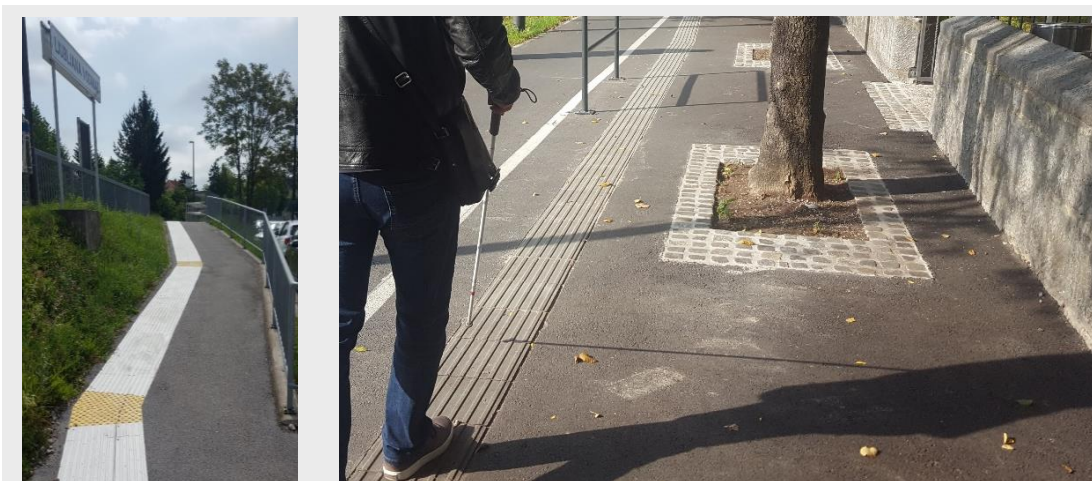
Sliki 24: Talni taktilni vodilni sistem niso samo taktilne oznake 1 (neustrezno): Taktilna vodilna linija je postavljena ob robu. Ta je že sam zelo dobro zaznaven, zato linija v takšnem primeru ni potrebna. Stroški izvedbe in vzdrževanja so tako po nepotrebnem zelo visoki, taktilna linija pa tudi zelo močno vpliva na podobo prostora. 2 (ustrezno): Primer, ko je standardno taktilno vodilno oznako nujno načrtovati zato, da se pešec z okvaro vida lahko izogne oviram, ki so ob robu in jih ni mogoče umakniti.
