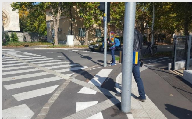
Slika 1 (neustrezno): Primer, kjer bi bilo zaradi pomanjkanja prostora nujno izvesti skupno površino za pešce in kolesarje. Kolesarski pas teče ob cesti, talne označbe so zelo kaotične, semaforji stojijo na kolesarskem pasu, pešci ne vedo, kje je varna površina in kje lahko stojijo.
