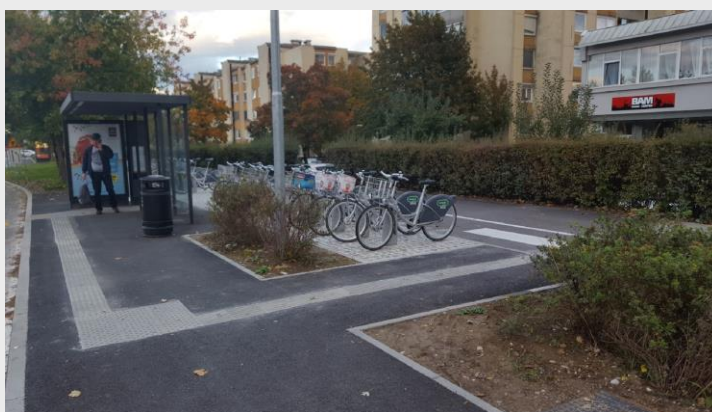
Slika 21 (ustrezno): Primer postajališča, kjer zaradi parkirišča za kolesa oznaka vstopnega mesta ne more biti neposredno vezana na rob, ampak jo je treba povezati s čepastimi polji in vodilnimi linijami.
