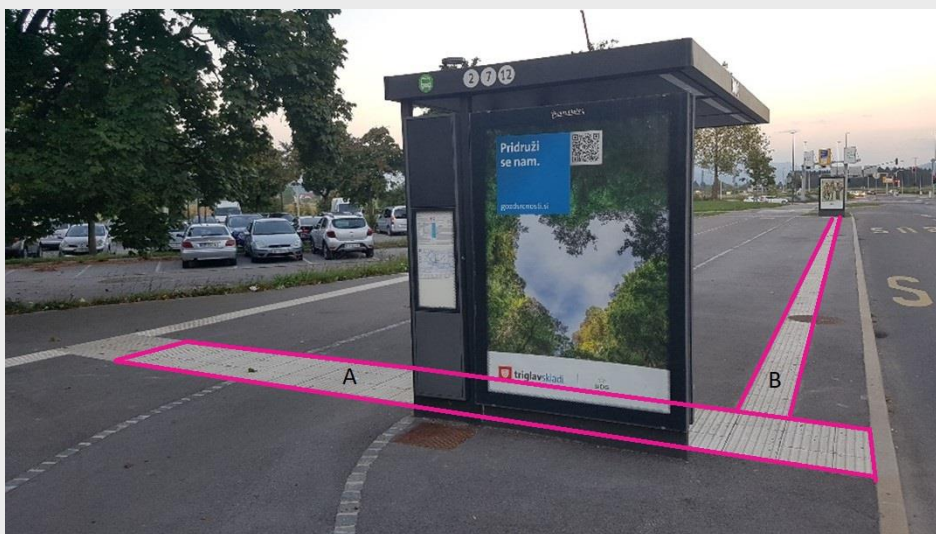
Slika 20 (ustrezno): Primer postajališča, označenega s kombinacijo standardnih oznak – del ob vstopnem mestu. Oznaka vstopnega mesta (A) je postavljena tako, da poteka neposredno ob informacijskem stebru. Taktilna vodilna linija (B) poteka vzdolž celega perona 60 cm od robnika ob cesti in se (brez čepaste oznake!) pripenja na oznako vstopnega mesta. Ta linija je pomembna zato, da pri izstopu iz avtobusa uporabnik bele palice lahko najde pot do roba pločnika.
